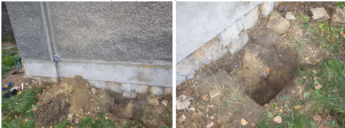
Foto č. 9-12 – K 3/1– celkové pohledy, skladba podzákladí, detaily rozvrstvení;
