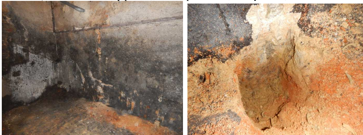
Foto č. 15;16 – K 4– celkový pohled, skladba podzákladí, detaily vrstev;
