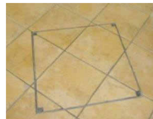
NUTNÉ NAVÁZÁNÍ SPAR DLAŽBY
